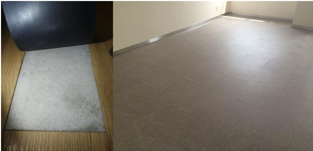
上图即为压敏胶粘贴的地板,可以轻松揭开,没有剥离强度,地板极易翘边。
