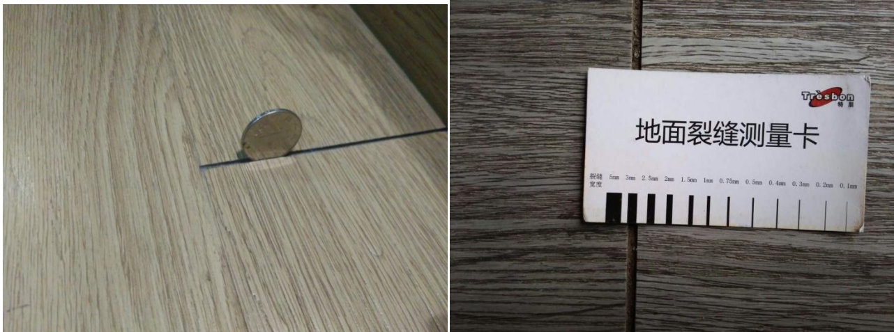
上图即为地板收缩后的缝隙,非常影响观感。
